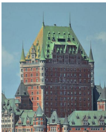
Patine en carbonate de cuivre du château de Frontenac (Québec)
