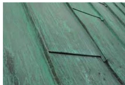
Toiture en cuivre oxydée
