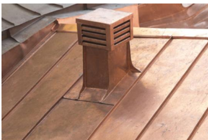
Toiture en cuivre non oxydée
