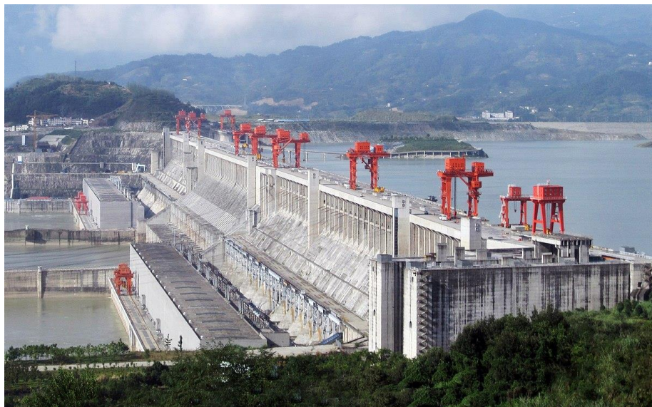
Barrage des trois gorges en Chine
